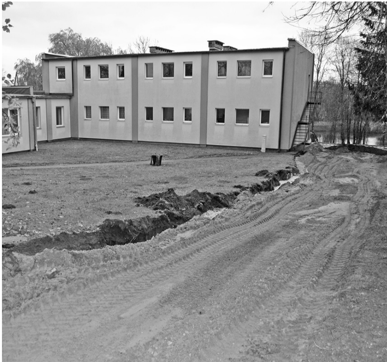
Bikstu ciematā pašlaik notiek centrālo brauktuvju remonts.
